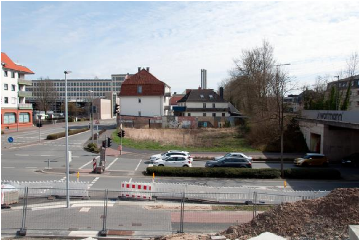
Abb. 9: Unbebaute Kriegslücke, Wotanstraße, Ecke Paulinenstraße, rechts das Bombardierungsziel Bahnüberführung, Zustand 2019. (Foto: Joachim Kleinmanns)
