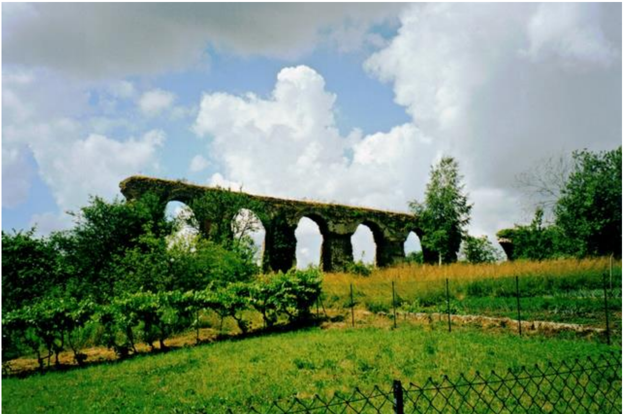
Abb. 4: Der römische Aquädukt zwischen Ars-sur-Moselle und Ancy-sur-Moselle. (Foto Verf., 2005)
