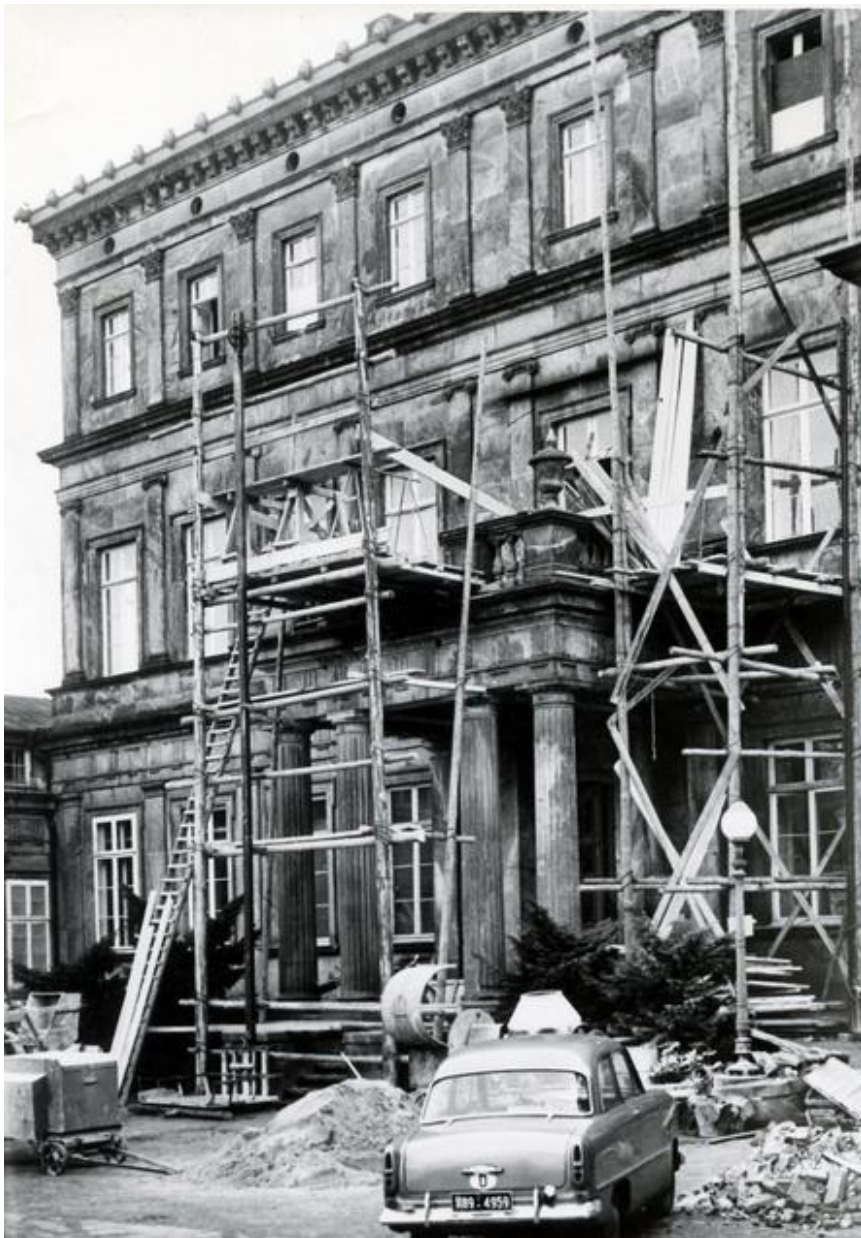
Abb. 4: Ausbesserung der Granateneinschlags-Schäden am Neuen Palais, undatiert. (Foto: anonym, Lippische Landesbibliothek, BA DT 14-68)
