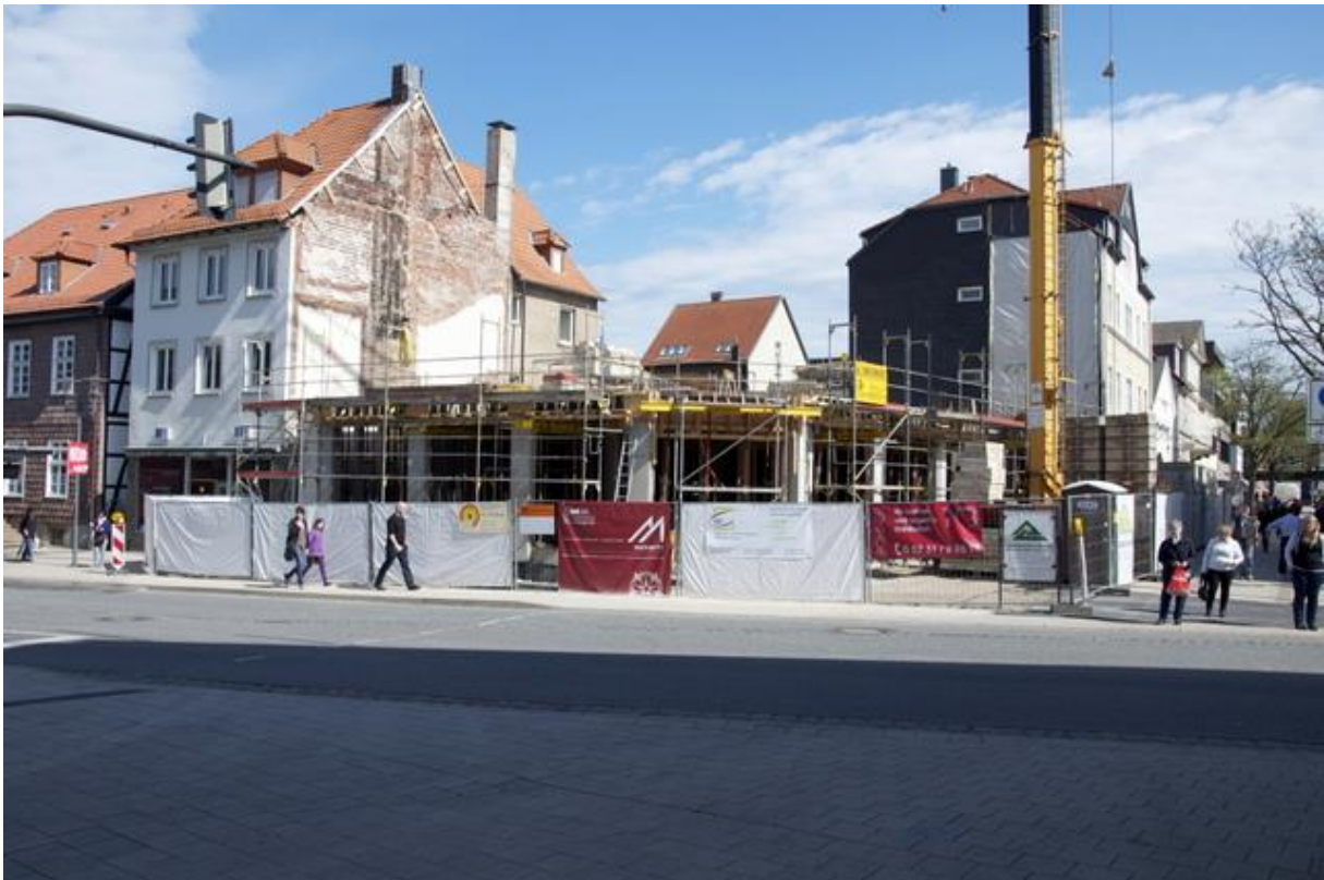
Abb. 13: Abriss des Quelle-Kaufhauses, Lange Straße 72, 2011. (Foto: Joachim Kleinmanns)
