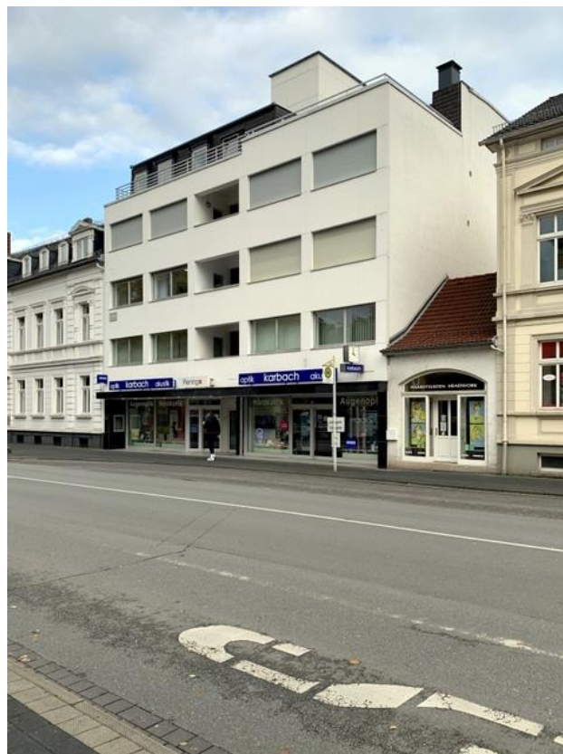
Abb. 12: Paulinenstraße 35 (bis 1970 Hausnummer 21), Wiederaufbau nach Totalschaden, Zustand 2020. (Foto: Joachim Kleinmanns)
