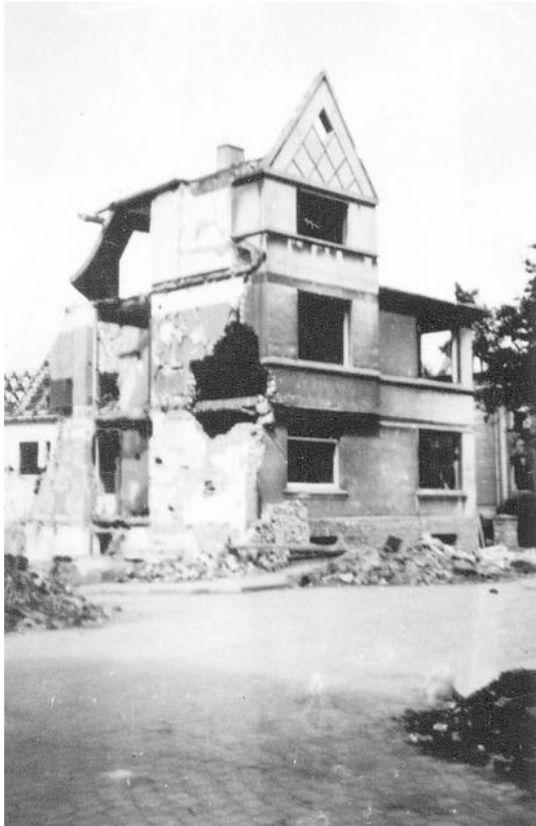
Abb. 1: Haus Niedermeier, Wiesenstraße 6, nach dem Bombentreffer vom 24. März 1945. (Foto: August Blanke, Stadtarchiv Detmold, Bildarchiv Nr. 2183)
